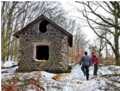
Restaurierungs-Objekt "kleines Basalthaus"
